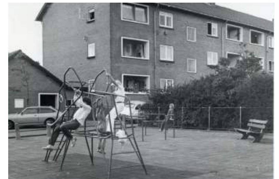
Historische foto: Hof aan de Jacob Roggeveenstraat
