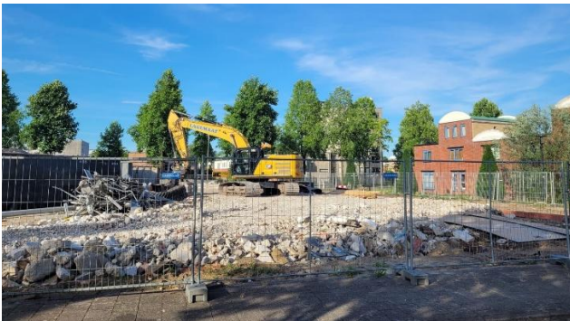
Sloopwerkzaamheden door Lagemaat sloopwerken
