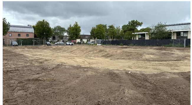
Sloopwerkzaamheden zijn afgerond
