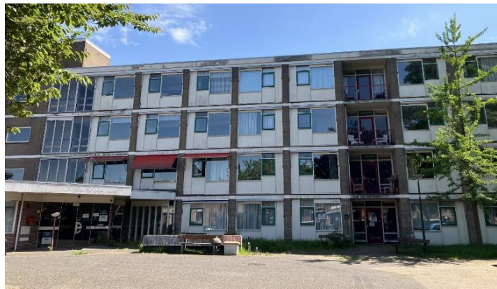
Foto: Bestaand woongebouw Groot Engendaal.
