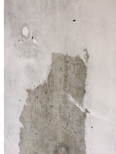
Foto betonwand met luchtbellen 1
